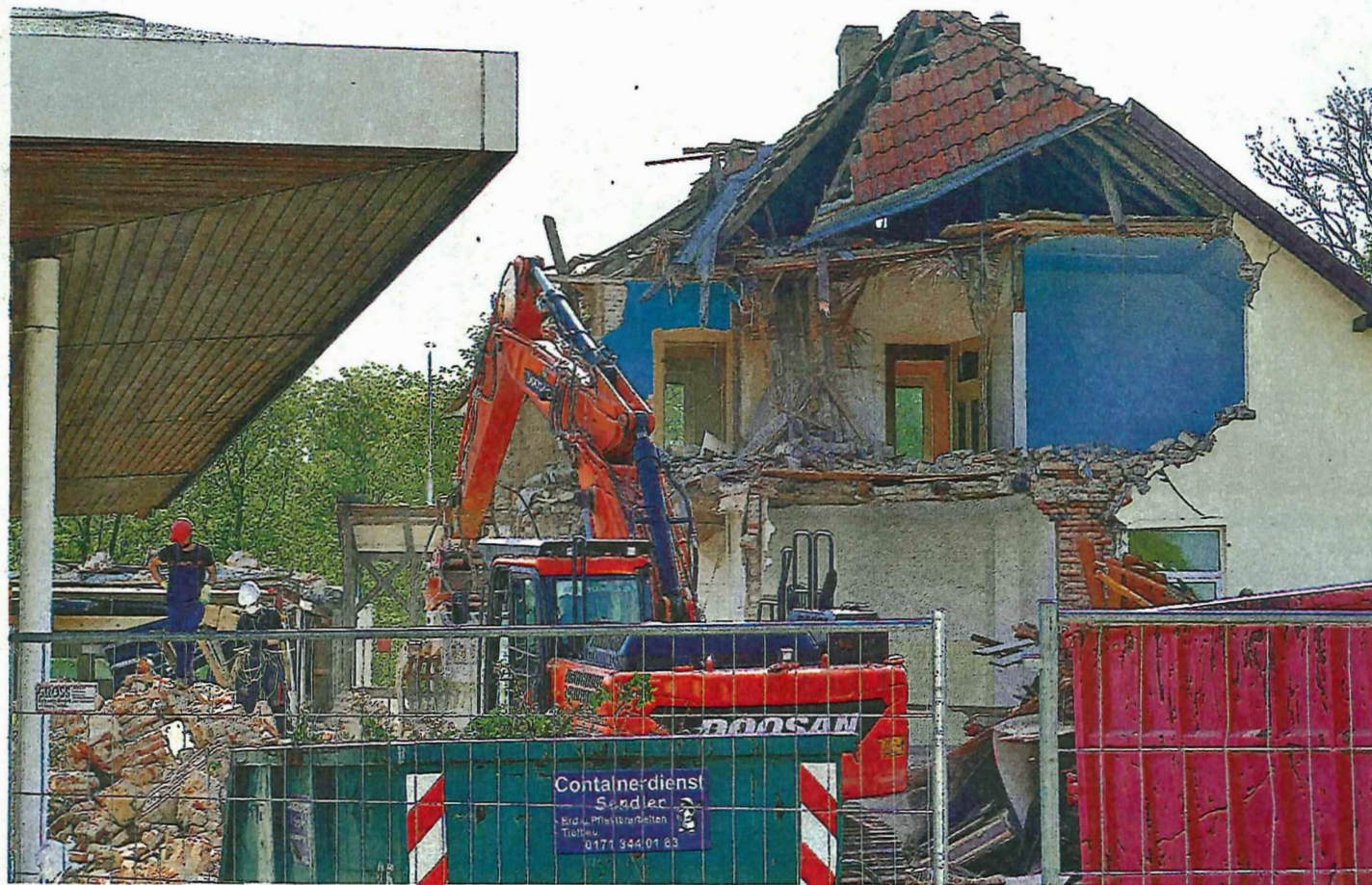
Beginnen haben die Abrissarbeiten auf dem ehemaligen Wecke-Gelände an der Oberntorstraße.
